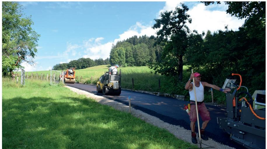
**Das eingefräste Planiematerial wird mit einer Asphaltdecke versehen;**
